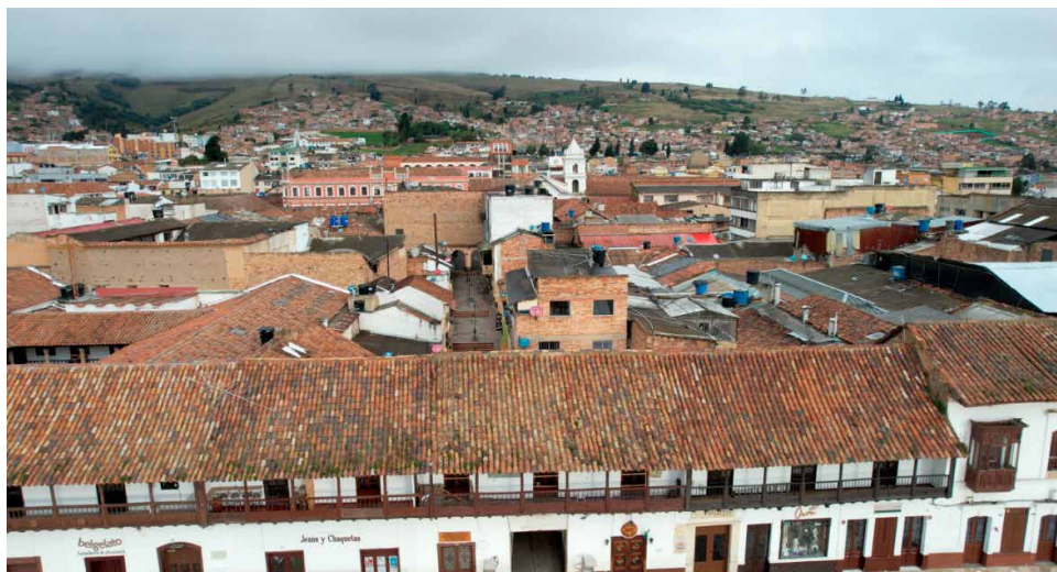
Fotografía 13. Vista aérea del Pasaje Vargas, entrada por la calle décima.
