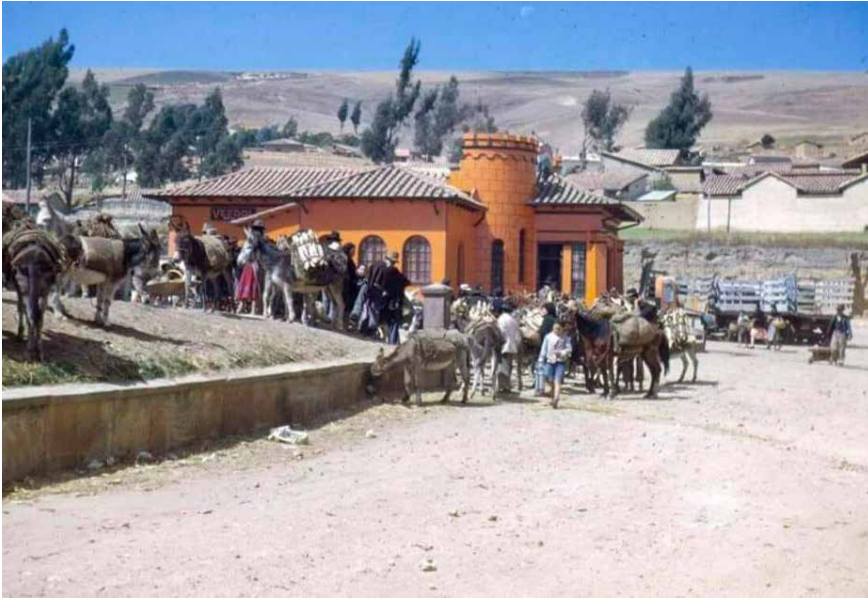
Fotografía 11. Estación de Servicio de Daniel Espinosa, 1948.
