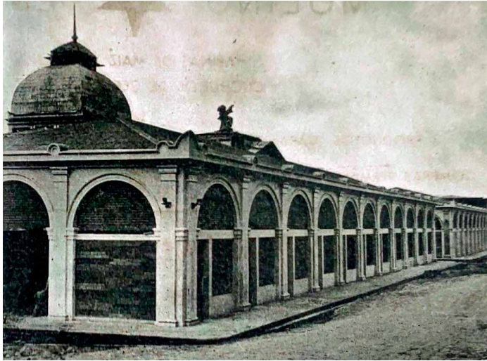
Fotografía 8. Aspecto parcial del edificio de Plaza de Mercado, 1939.
