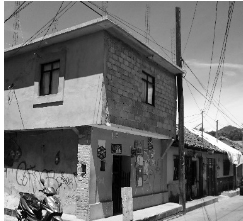
Figura 53. Hogar con losa de concreto, 2015. Foto: Juan Carlos Velasco.
