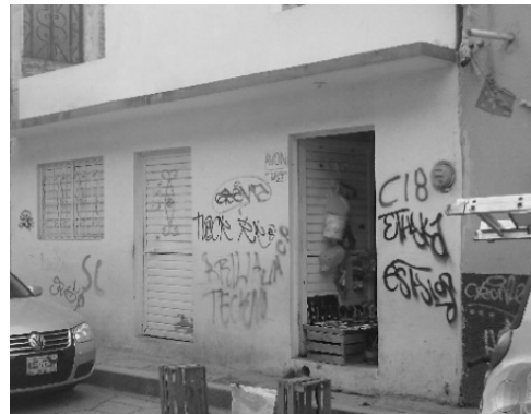
Figura 51. Hogar con pared y losa de concreto. 2015. Foto: Juan Carlos Velasco.
