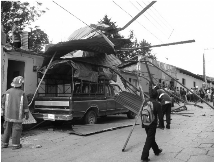
Figura 19. Estructura metálica y láminas sobre el carro, barrio Mexicanos. Foto: Tomada de Velasco (2012) 5 .
