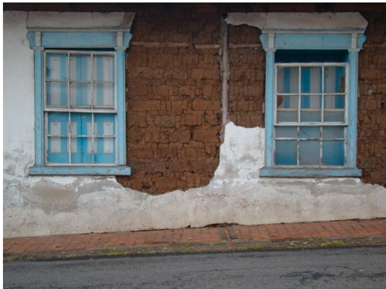
Detalle de ventanas en casa de adobes de Santo Domingo de Heredia. Fotografía: David Boza Méndez.
