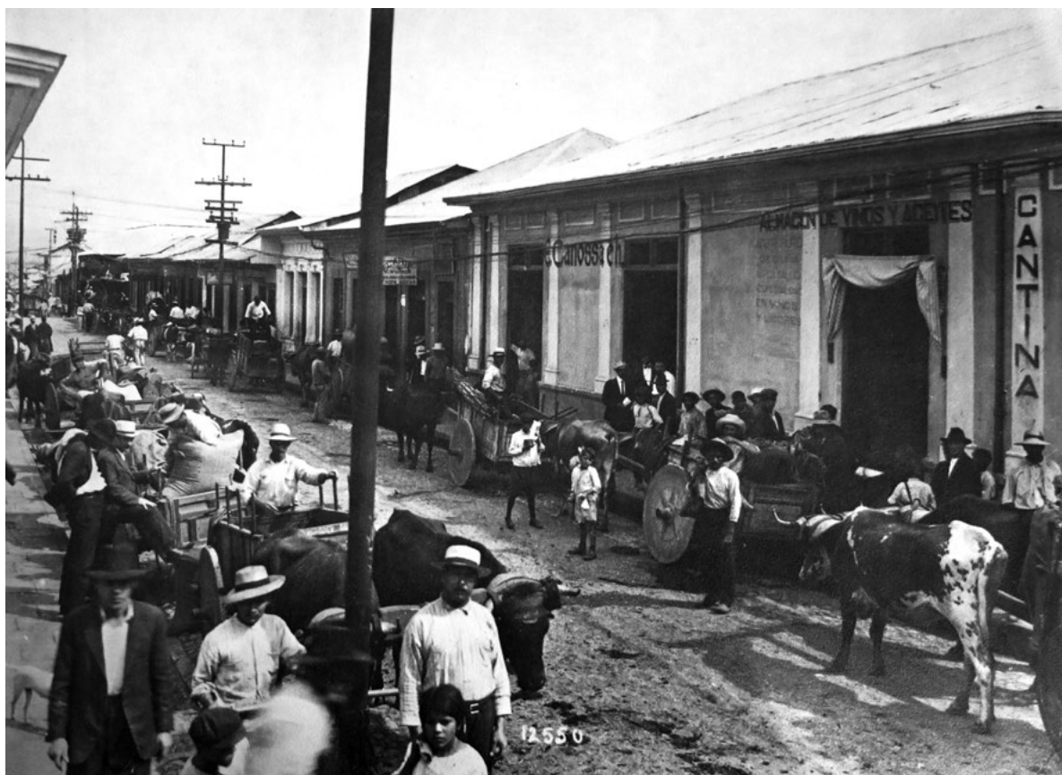
Esquina noroeste del Mercado Central. Calle 8.ª hacia el norte. Fotografía: Manuel Gómez Miralles, 1921. ARCHSV.
