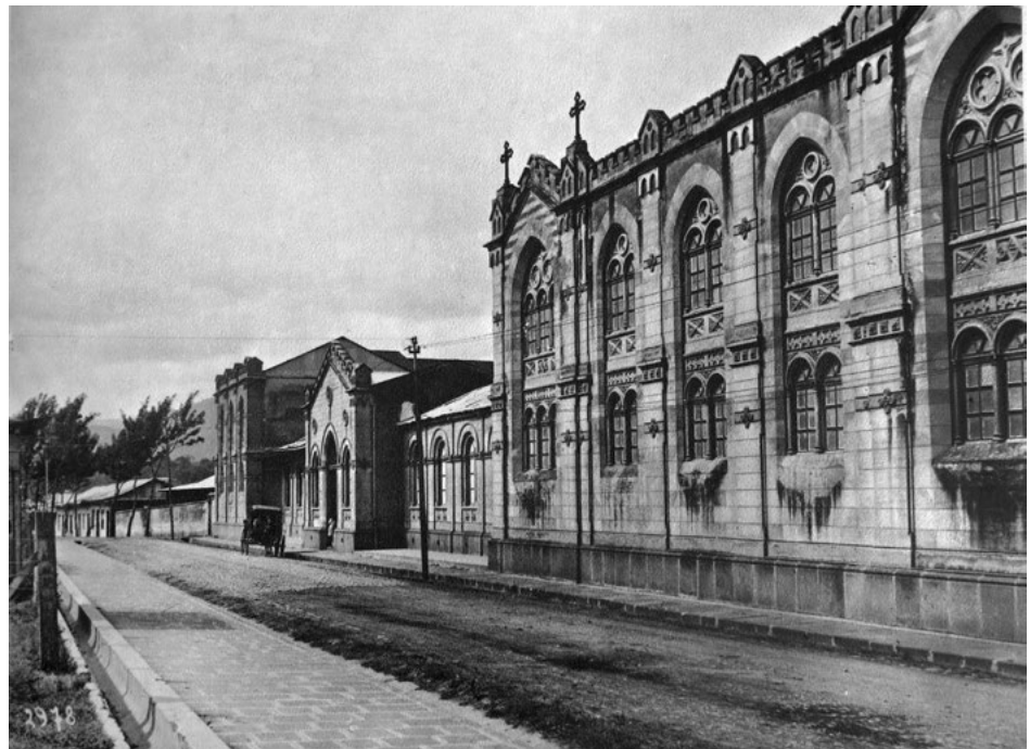
El Hospital San Juan de Dios. Fotografía: Manuel Gómez Miralles, 1922. ARCHSV.
