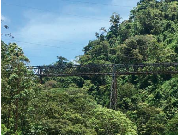
VISTA PANORÁMICA DEL PUENTE SOBRE EL RÍO BIRRÍS (fotografía proporcionada por el autor).
