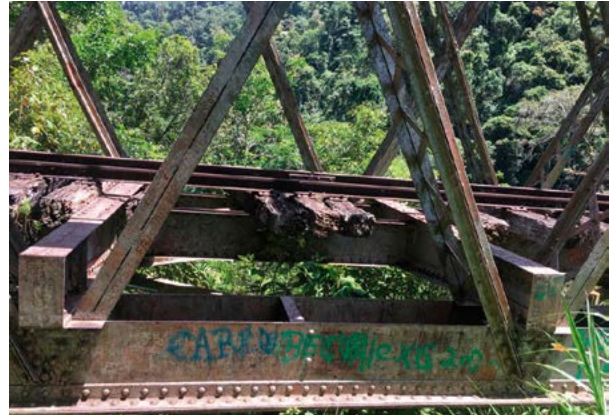
DETALLE DEL PUENTE SOBRE EL RÍO BIRRÍS (fotografía proporcionada por el autor)
