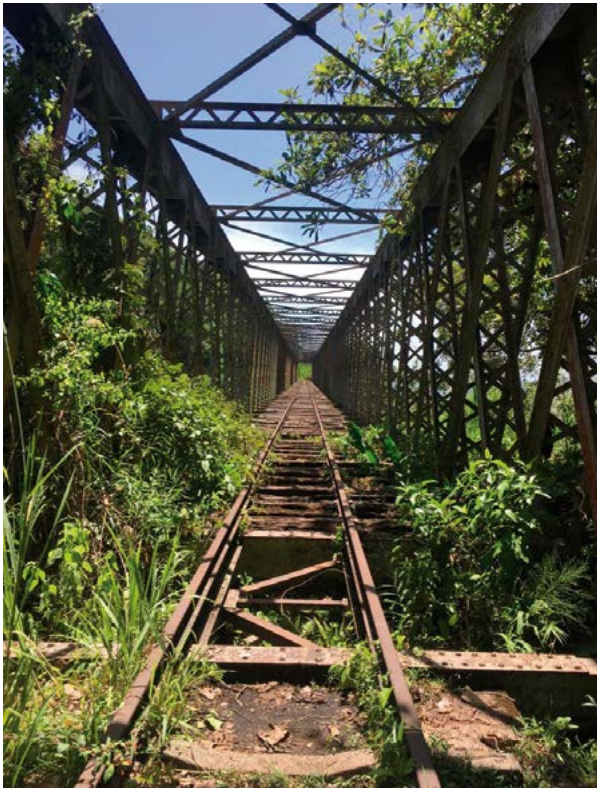
PUENTE SOBRE EL RÍO BIRRÍS (fotografía proporcionada por el autor)
