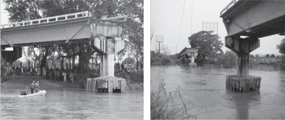
**Figura 7.3.** Desaparecieron 80 metros, de un total aproximado de 1 km de largo, del puente del río Amecca, el cual divide al estado de Nayarit de Jalisco, el día 29 de agosto de 2010
