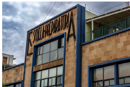
Imágenes 35-37. Fachada del edificio de Álvaro Obregón n.º 308, 2024. Autor: Fernando Alvarado Herrera.
