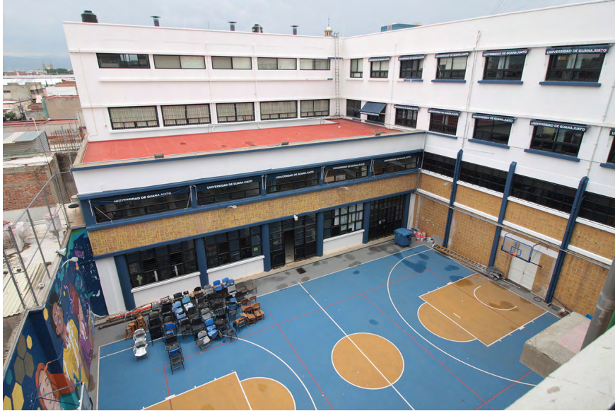
Imagen 55. Patio izquierdo del edificio de Álvaro Obregón n.º 308, 2024. Autor: Jaime Alfredo Bailléres Landeros.
