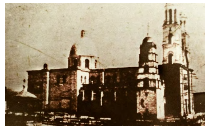
Ilustración 1. Construcción de la actual catedral a finales del siglo XIX.
