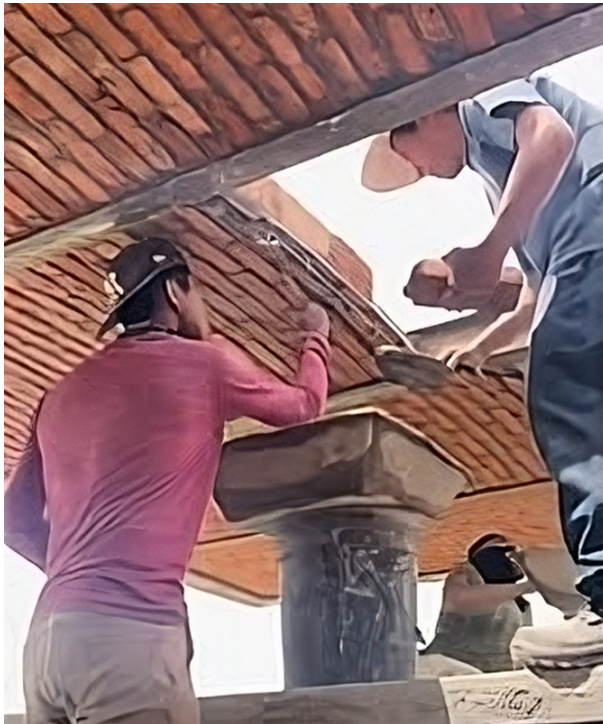
Figura 1. Construcción tradicional de techo de bóveda
