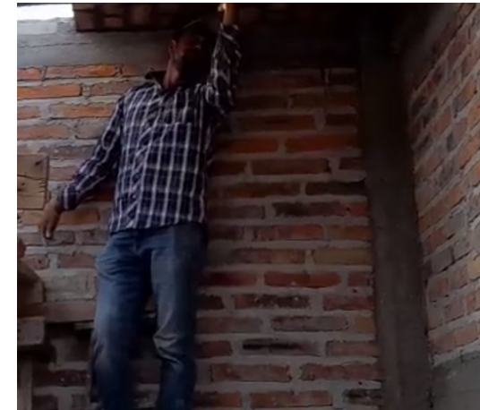
Figura 2. Bóveda nivel alto
