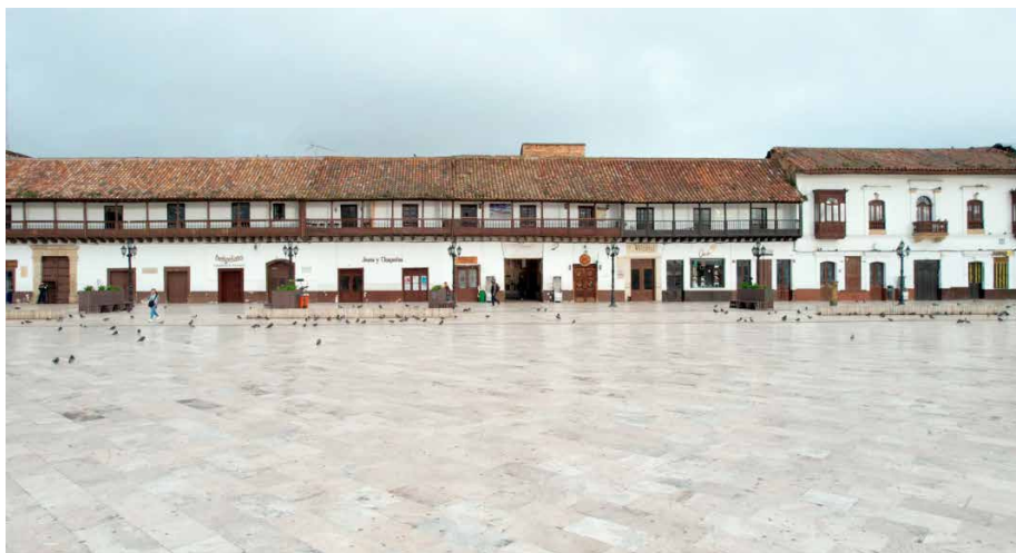
Fotografía 12. Estado actual de la Plaza de Bolívar, entrada por la calle décima al Pasaje Vargas.
