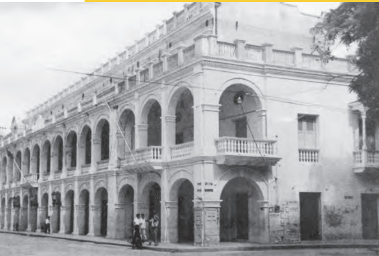
Edificio de la Gobernación de Bolívar, Cartagena. 1970.
