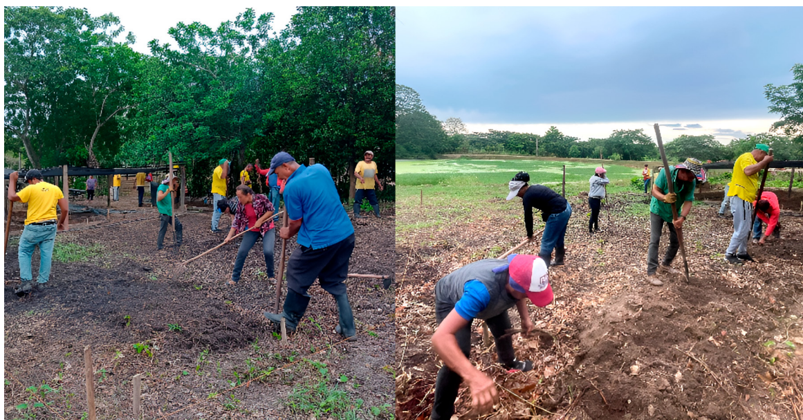
Limpieza del terreno.
