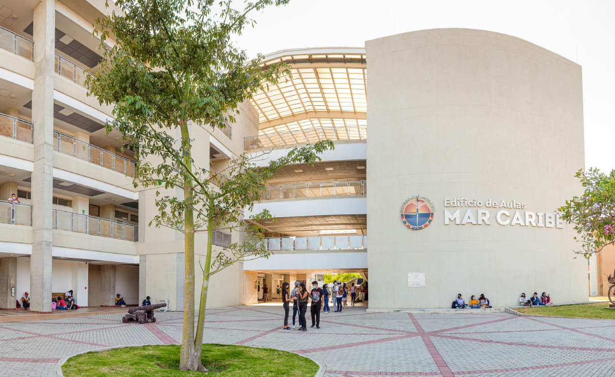
► Edificio de Aulas Mar Caribe.
