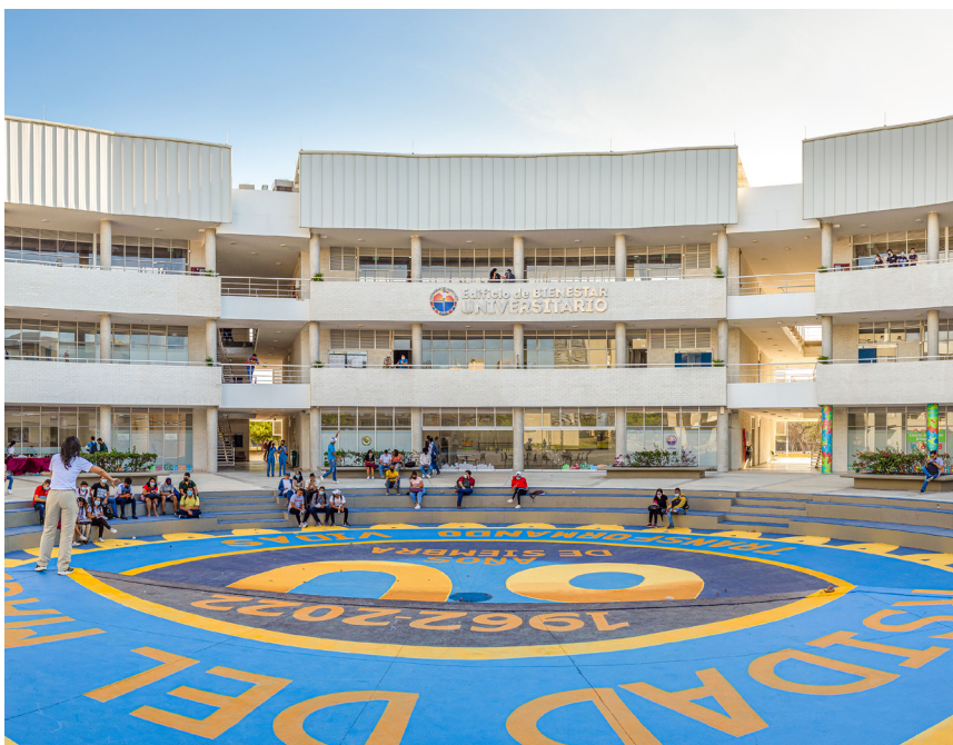
► Edificio de Bienestar Universitario
