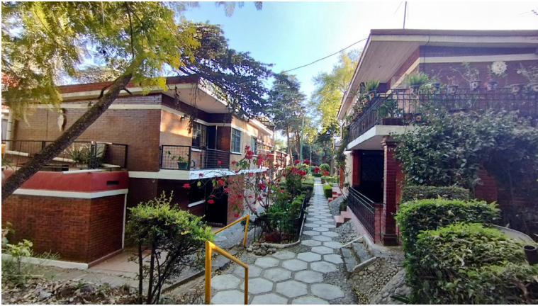
Figura 31. Espacio comunitario entre hileras de casas dúplex, donde se aprecian los jardines intermedios, la adaptación de las viviendas a la topografía y la buena conservación de las casas que lucen su estado original.
