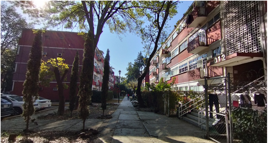
Figura 8. Edificios multifamiliares tipo D, los únicos que permanecieron en pie luego de los terremotos y los derribos por explosiones.
