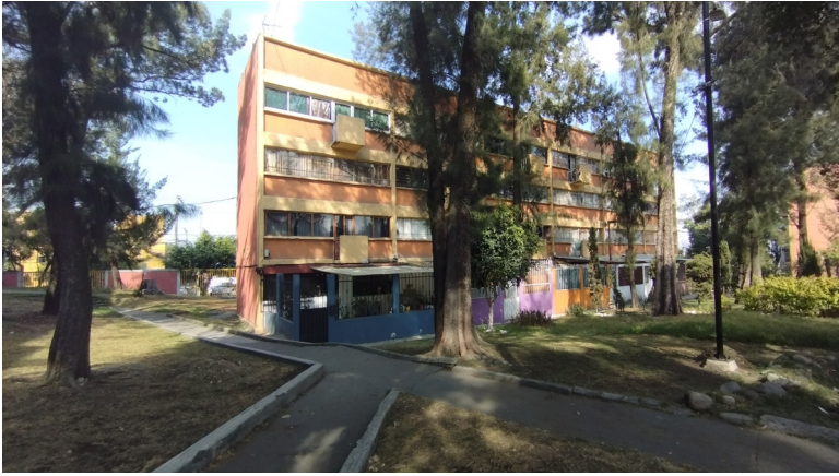
Figura 12. Multifamiliar tipo B, con las plantas bajas transformadas por sus moradores, dando a entender la necesidad de una conexión diferente entre edificio y suelo.
