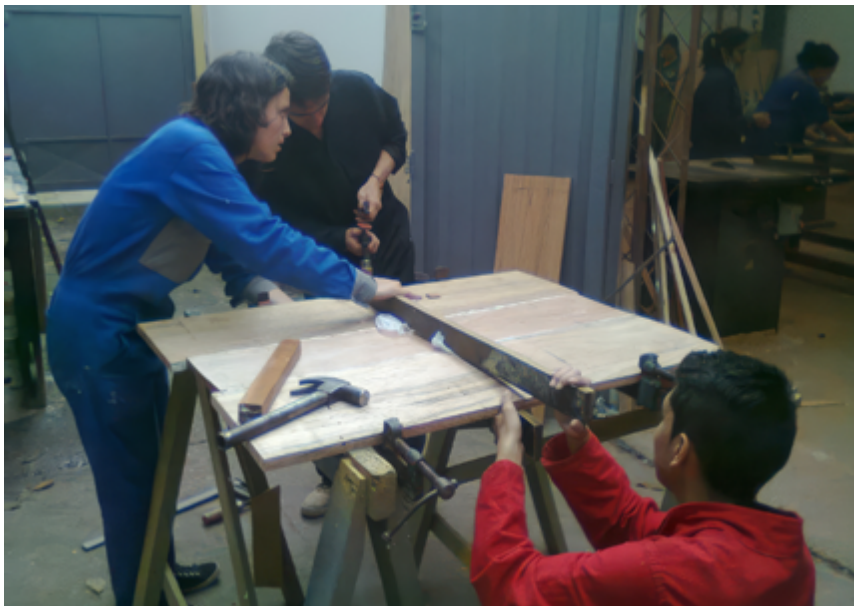
Figura 72. Armado de tablero de madera maciza de cedro achapo, con alacranes, prensas y adhesivos
