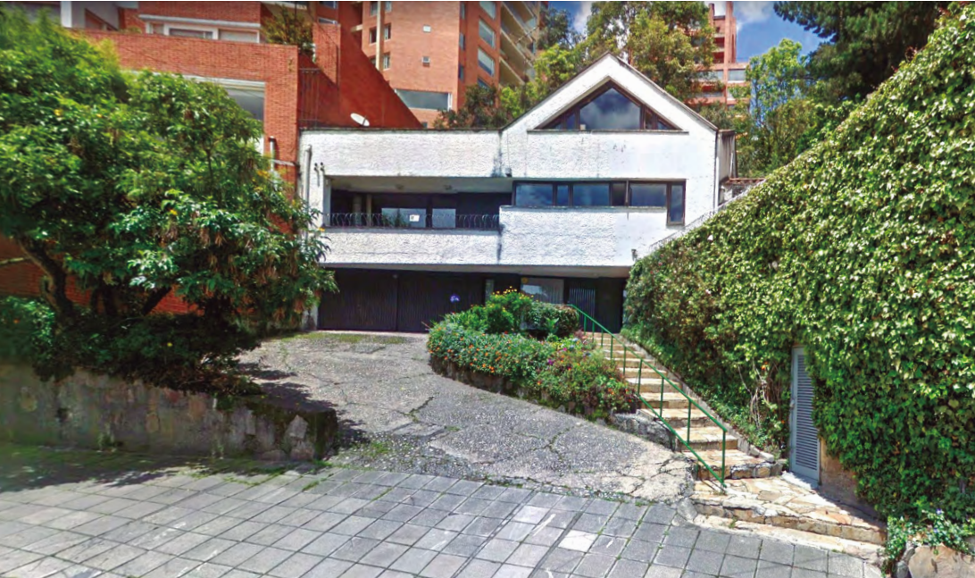
1. Fachada sobre el acceso.
