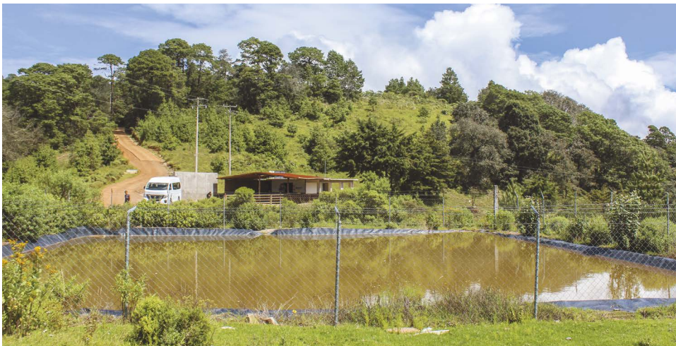
Figura 9. Estanque construido recientemente cerca de Cuatro Palos, Pinal de Amoles, revestido con geomembrana, el cual se llena sobre todo con agua que baja del camino. Está cercado para mantener fuera al ganado y evitar daños en el revestimiento
