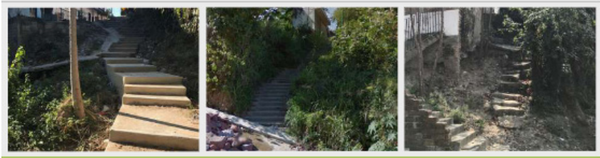
Punto 10. Escalinatas de material (block, varilla y cemento), obra pública por parte del Ayuntamiento, ubicadas en la calle Alameda, colonia El Coapinole.
