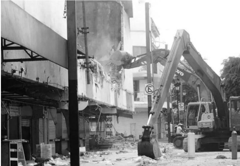
Imagen 22. Mercado Corona después del incendio de 2014, en proceso de demolición. Recuperado de: https://www.excelsior.com.mx/nacional/2014/05/07/957958
