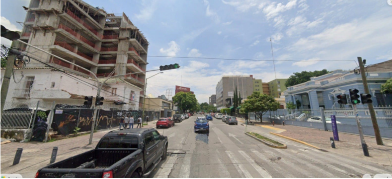
Figura 5. Av. Américas al cruce de calle Progreso (Julio, 2024). Contraste de edificio en construcción con finca patrimonial.
