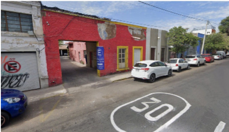
Figura 3. Calle Francisco I. Madero 673 (2024). Finca de adobe convertida en estacionamiento.
