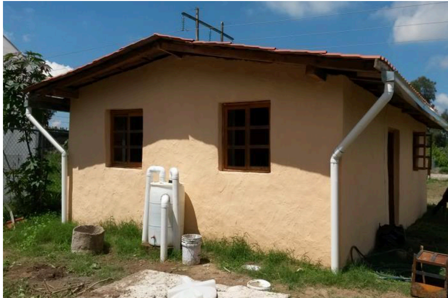
Imagen 11. Casa de paja en CUCBA-UdeG, construcción sustentable de factura en paja y ferrocemento. Fuente: Imagen propia (2017).
