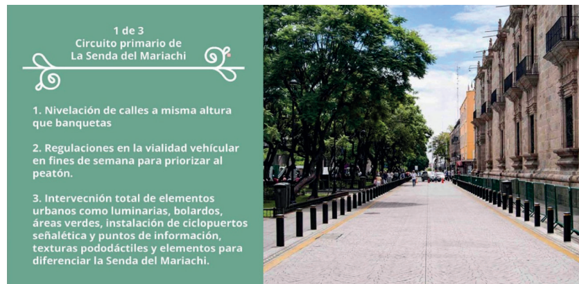
Figura 56. Nivelación de calles a la misma altura que banquetas
