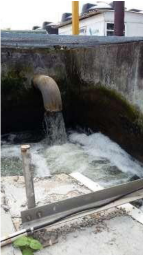
Figura 16. Punto de mezcla y desinfección de los efluentes de los procesos de aireación extendida y biodigestores. Elaboración propia.
