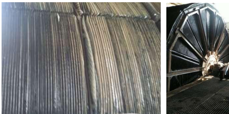
Figura 12. Unidad de biodiscos sin crecimiento de la biopelícula sobre los discos y por lo tanto no hay una adecuada remoción de contaminantes. Elaboración propia.
