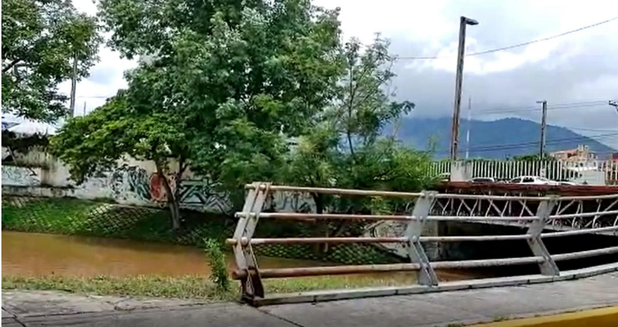
Remanso de agua dentro del canal principal del RM provocado por el puente México el 13 de agosto del 2022. Foto tomada por Julián Gazcón Ocádiz.
