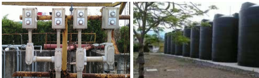
Figura 15. Proceso de biodigestores en planta La Cantera. Izquierda, línea de alimentación del cárcamo a los biodigestores. Derecha, módulo I de Biodigestores en serie. Elaboración propia.
