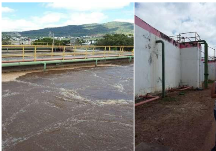
Figura 14. PTAR La Cantera Proceso de Lodos Activados. Izquierda. reactor de aireación extendida. Derecha, salida de clarificador secundario. Elaboración propia.
