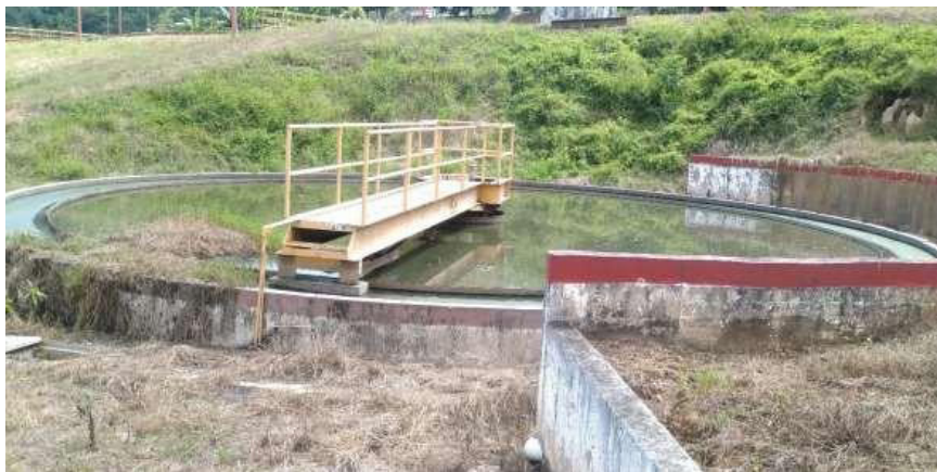
Figura 34. Clarificador secundario del proceso de biodigestión anaerobia fuera de operación. Se observa el crecimiento de vegetación dentro del clarificador. Elaboración propia.
