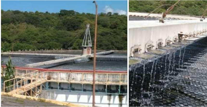
Figura 28. Filtro percolador en funcionamiento. A la izquierda vista general, se observa que el efluente no sale a lo largo de todos los bazos. Derecha, detalle de mala alimentación. Elaboración propia.
