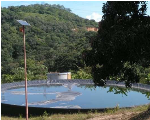
Figura 33. Biodigestor instalado en uno de los sedimentadores primarios de la PTAR El Punto. Se observa geo-membrana sin presión interna de biogás. Elaboración propia.
