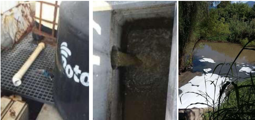
Figura 13. Izquierda, cloración del efluente sin dosificador a la salida del proceso de biodiscos. Central, efluente de la PTAR. Derecha, descarga del emisor de la PTAR Xalisco en el río Mololoa, al fondo de la imagen se observa la entrada de contaminación al río. Elaboración propia.
