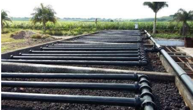
Figura 4. Proceso de filtro percolador sobre tezontle en rehabilitación, PTAR Xalisco. Elaboración propia.
