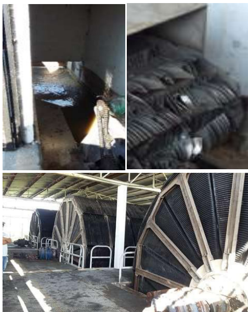
Figura 10. Superior izquierda, influente de agua residual a PTAR Xalisco 2. Superior derecha, cribado del agua residual. Inferior, módulos de biosólidos (capacidad de 20 Lps c/u). Elaboración propia.
