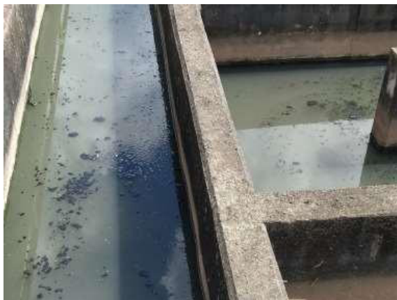
Figura 30. Sistema de cloración con lodos biológicos provenientes del sedimentador secundario. Elaboración propia.
