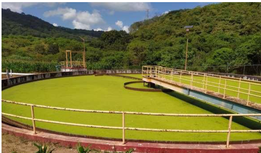
Figura 35. Reactor final de aireación adecuado en uno de los clarificadores secundarios de los trenes de tratamiento originales. Se observa que está fuera de operación desde hace un periodo prolongado de tiempo. El color es debido a un crecimiento de algas por exceso. Elaboración propia.
