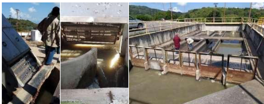
Figura 26. Llegada de agua residual cruda a la PTAR El Punto. Izquierda, criba descompuesta. Centro, desvió el flujo hacia la PTAR y hacia el riego de cañaverales. Derecha, desarenadores. Elaboración propia.
