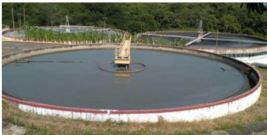
Figura 27. Sedimentador primario del tren de tratamiento original en operación. Elaboración propia.
