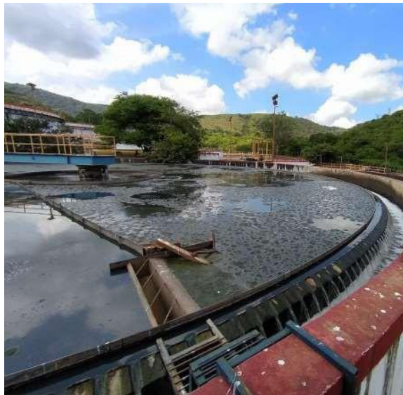
Figura 29. Reactor secundario con flotación de lodos biológicos. Elaboración propia.
