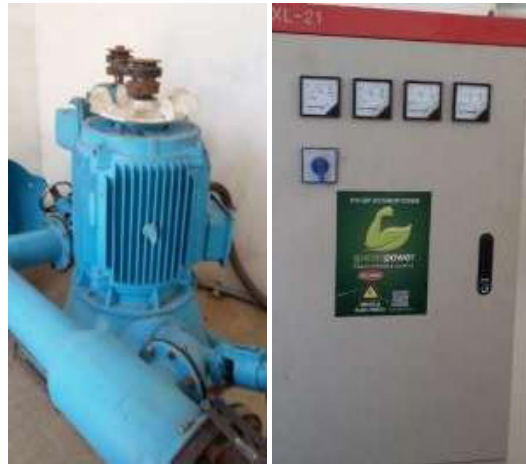
Figura 32. Equipo de generación de energía por caída por gravedad del influente de agua residual cruda a la entrada de la PTAR El Punto. Izquierda, motor generador. Derecha, tablero de control. Elaboración propia.
