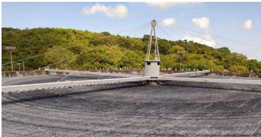
Figura 36. Filtro percolador de una de las líneas de tratamiento fuera de operación, sin biopelícula y completamente seco. Se observa que este proceso lleva un largo periodo de tiempo fuera de servicio. Elaboración propia.
