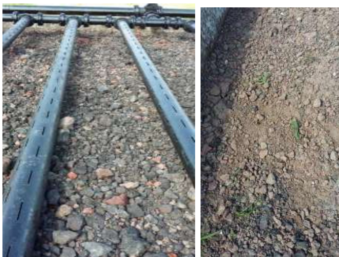
Figura 5. Granulometría deficiente de la nueva cama de tezontle con alta presencia de finos. Elaboración propia.
